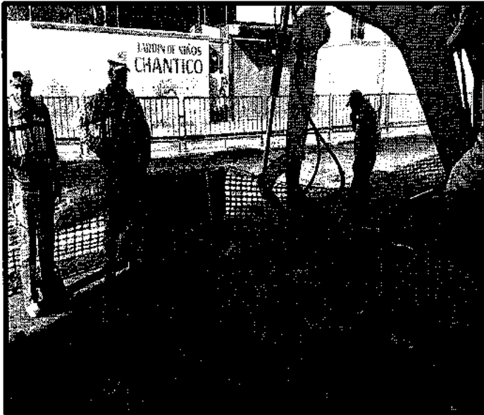
Cala de verificación para detección de infraestructura subterránea sobre la calle Juan de Dios Peza, esq. San Rafael Atlixco, Col. Santa Ana Poniente.
